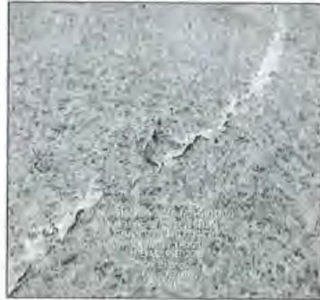
Además, debido a que las fallas son estructurales en la losa y base, y el nivel de daño que presentan las grietas es medio, las cuales son progresivas y afectan la capacidad de carga y circulación, ponen en riesgo la inversión realizada; por lo tanto, la deficiencia no se subsana.
