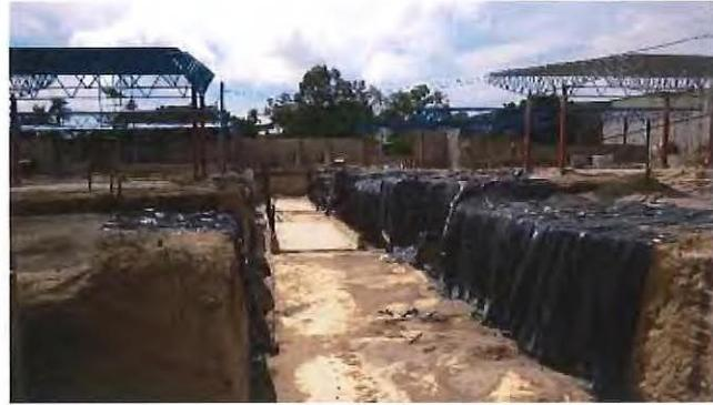
A pesar de haber protegidos con plástico los muros del túnel, estos han sufrido daños de erosionamiento, socavamiento, agrietamiento, y en la base del piso se ha producido asolvamiento, debido a la cantidad de tierra que se ha arrastrada por la escorrentía superficial, concentrando la en la parte inferior; además es evidente el daño a la base donde van colocada las losas, ya que se han producido asentamientos, producto de la humedad que se ha infiltrado al suelo compactado.
