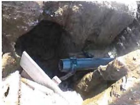
Socavamiento en la fundación para pozos de aguas lluvias.
