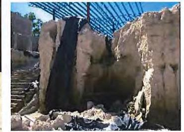
Erosionamiento y socavamiento de paredes del Túnel
