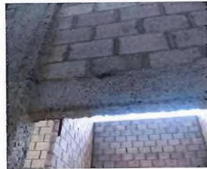
Se verifico que muchas de las estructuras de concreto han sido escarificadas quedando visible en algunos casos la estructura de hierro del elemento y además deja en evidencia el inadecuado proceso constructivo y la deficiente Supervisión en cada uno de los procesos constructivos.
