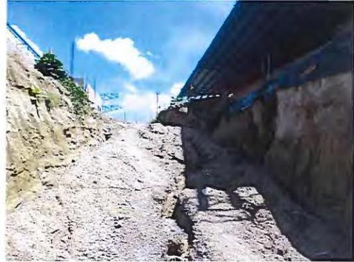
Vial 1 Sur y Acceso Oriente Erosión de la rampa de descenso al Túnel conformada en el Vial 3.
