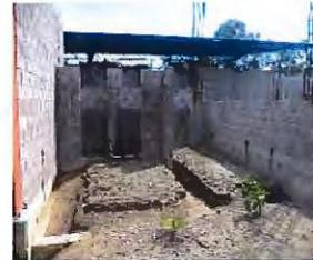
Fundaciones sin haber sido selladas y las cuales han sido inundadas por las aguas lluvias, generando además infiltración de aguas lluvias
