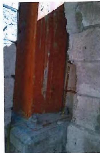
Columna metálica corroída y la deficiente modulación del bloque.
