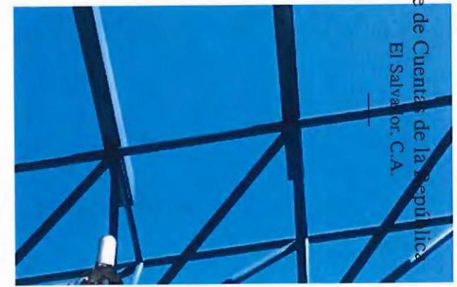
Deficiente proceso en la aplicación de la pintura anticorrosiva ya que esta no ha sido aplicada uniformemente y las capas no han sido pintada completamente para iniciar la siguiente; además existe corrosión en muchos puntos de la estructura.
