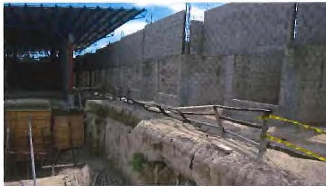
En el area de los locales comerciales del Modulo No A, el pasillo no es adeucado para que los trabajadores circulen, ya que existe riesgo de desprendimiento de la pared de tierra por el erosionamiento. Ademas la zanja ubicada en ese pasillo para la tuberia no ha sido sellada, dejando vulnerable la pared de tierra por la infiltracion de las lluvias
