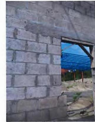
Inadecuada modulación de las paredes, ya que existe un saliente en la parte inferior
