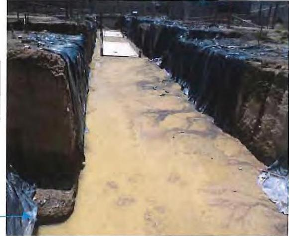
Al 21 de agosto del 2014, el área del túnel contenía dos lozas construidas, se ha inundado y azolvado toda el área, por la tierra que ha desprendido del erosionamiento de las paredes y por no contar con sistema de drenaje, perdiendo el área trabajada en compactación de suelo cemento, por el abandono de los trabajos de construcción.
