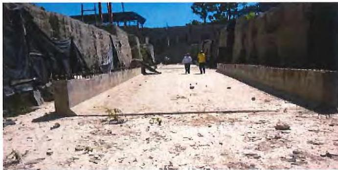
Las losas construidas presentan agrietamiento, el cual se observa que fue repellada para evitar que fueran tan visibles, sin llevar un proceso adecuado de reparación; Además se observa que producto de la infiltración de agua bajo las losas, se ha generado el asentamiento de ellas.
