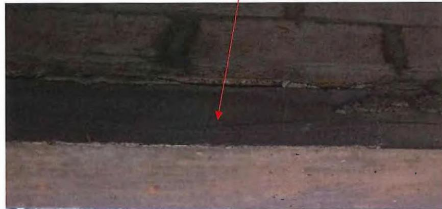
Paredes y cargaderos desalineados, siendo evidente la grada que se genera entre ellos, y al igual el deficiente pegado de los bloques.
