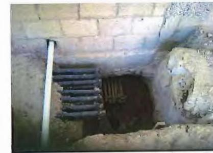
Excavaciones donde ira caja de registro para el sistema eléctrico, que ha tenido infiltración de aguas lluvias
