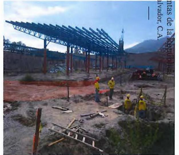
No se construyeron los muros perimetrales para el confinamiento del andén, azolvamiento en pozo de aguas lluvias,
