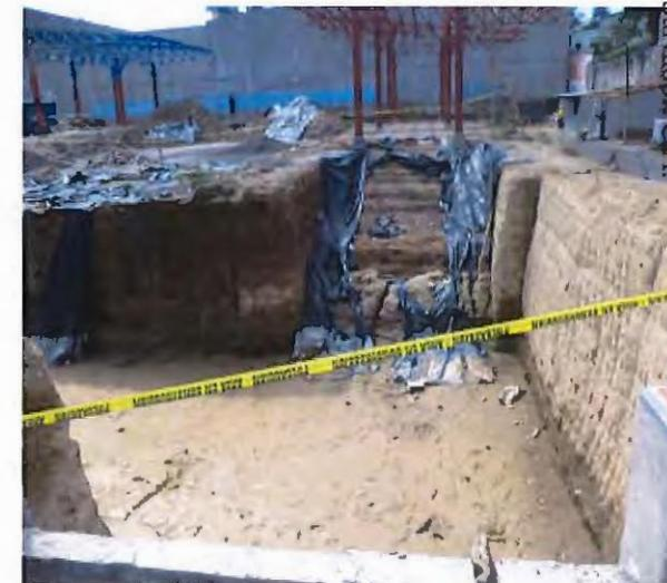
Al 13 de noviembre las gradas del Anden D, se encontraban erosionadas y muros de tierra agrietados
