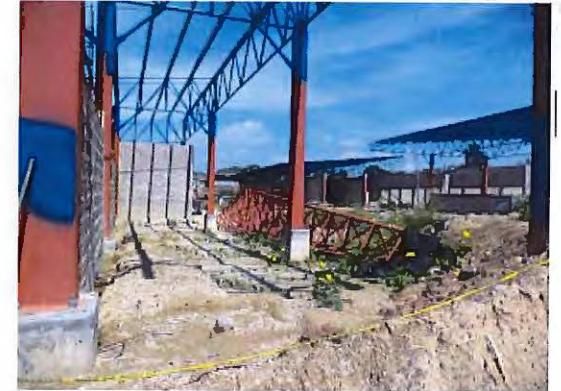
Se ha aplicado pintura anticorrosiva parcialmente, por lo que las lluvias la han corroído en la estructura.
