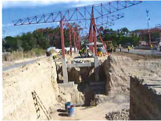
Estructura de Zapatas Tensores y pedestales vistos, que han dejado expuestos al invierno.
