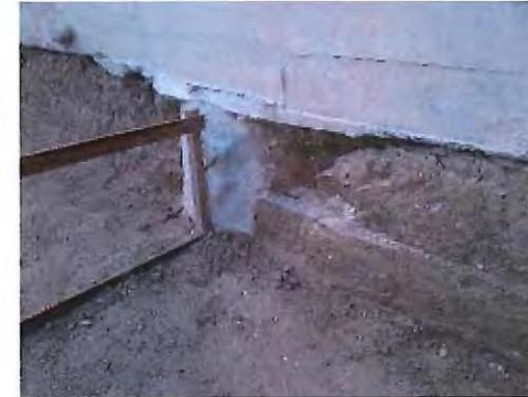
En visita del 11 de noviembre del 2014, la pared de colindancia de la Plaza Soyapango, únicamente se había realizado la excavación, sin contar con el diseño detallado de esta obra, profundizando aún más la excavación y dejando aún más vulnerable la fundación del proyecto.
