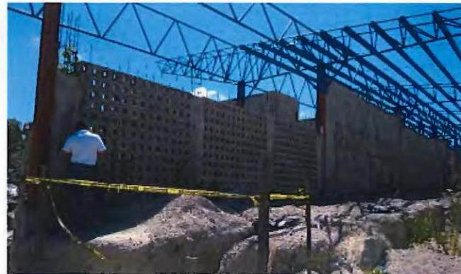
Erosionamiento del andén B, que han deformado la conformación de la terraza por falta de los muros de confinamiento para el nivel requerido de Andén B
