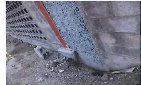
Escarificado de la estructura de columnas tipo castillo.
