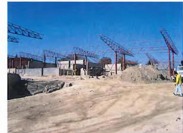
Al 18 de Agosto 2014, se ha colocado parte de la estructura metálica del techo y se ha pintado parcialmente.
