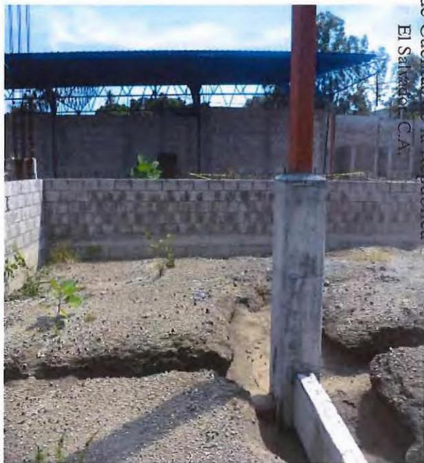
Infiltración de agua a las fundaciones de los pedestales y tensor.
