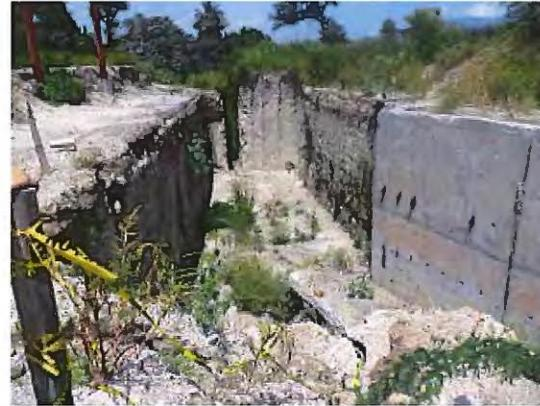
En 19 julio 2014 inicia el erosionamiento de la paredes de tierra de la Caja de Detencion
