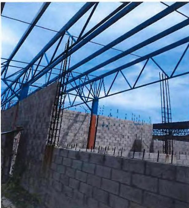
Hierro verticales que no poseen suficiente longitud para realizar el empalme adecuado de las varillas para la continuidad de la pared, además de la corrosión del hierro de los elementos estructurales de la pared.
