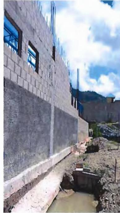
Paredes desniveladas a las que el encargado de Control de Calidad informa en Bitácora No 776, al Administrador de Contrato que a partir del cargadero se corregirá el desnivel y la parte inferior azotado de mortero mínimo de acción correctiva, entre b-7 y ejes 10 y 11
