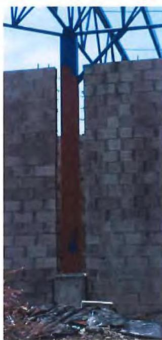
La estructura aprobada para el confinamiento de la pared debe ser una columna tipo castillo, de acuerdo con los planos de taller, sin embargo no se ha dejado el espacio que se requiere para la construcción de ella y no se encontró detalle adicional o cambio al elemento estructural que se utilizara en esta área.
