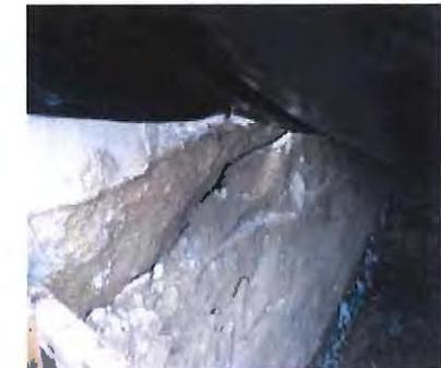
Las excavaciones realizadas han sido cubiertas con plástico, al observar esas áreas constatamos que se han generado grietas en el terreno, bajo la fundación del muro de la Plaza Soyapango
