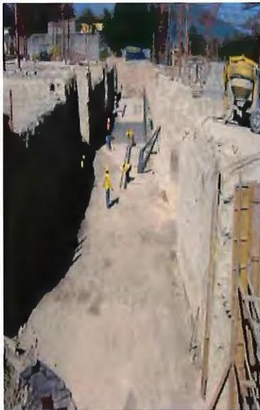
Mes de febrero del 2014, se había dado inicio a la instalación de la armadura del túnel, y se han excavado los huecos donde irán ubicado los cubo del ascensor y se inicia la armadura de las losas de concreto del túnel
