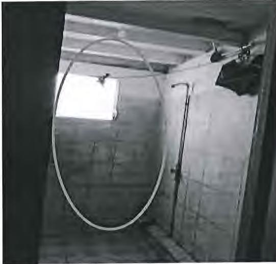
Las Paredes y pisos de los baños se encuentran en condiciones insalubres, con malos olores, fugas de agua y puertas dañadas.
