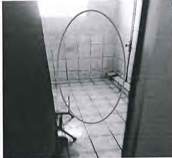
Existe fuga de agua ocasionando filtración en el nivel inferior, los azulejos y el inodoro se encuentran sucios y deteriorados.
