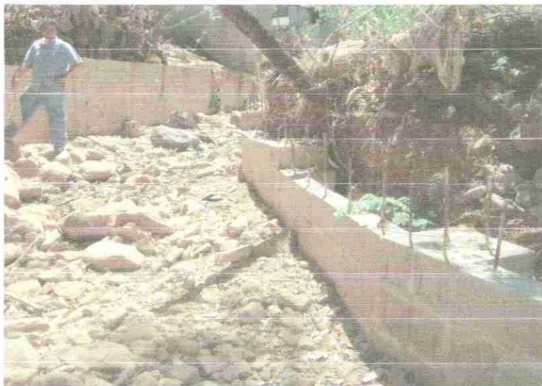
Muro Sin terminar
