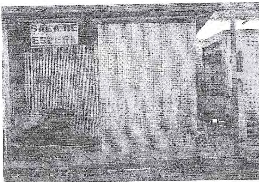
Instalaciones construidas de lámina
